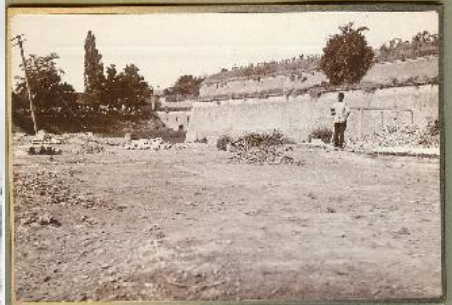
Bastion I und Schanze gegen die Westschanze von der Innenseite
