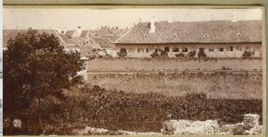
Hinter der Westschanze Bastion I
